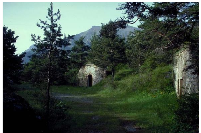
Batterie du Chatelard
